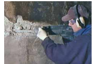
Rehabilitación Patch'n Plug & Megamix
