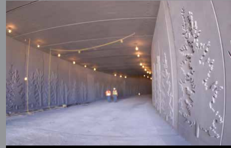
Túnel Bremerton, EUA
