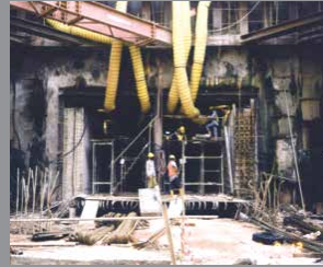
Concreto vertido en sitio
