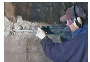
Rehabilitación Patch'n Plug & Megamix
