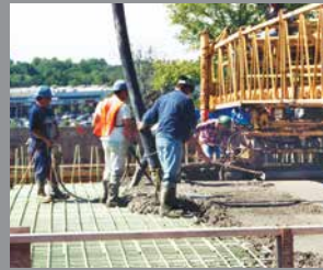
Concreto vertido en sitio
