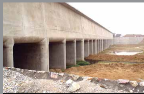
Proyecto de Transferencia de Agua Sur-Norte, China
