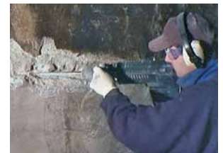
Rehabilitación Patch'n Plug & Megamix
