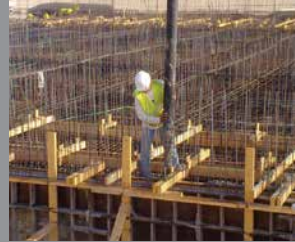
Concreto vertido en sitio
