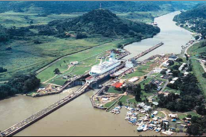
Canal de Panamá: Muros de las Esclusas de Gatún, Panamá
