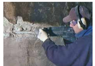
Rehabilitación Patch'n Plug & Megamix
