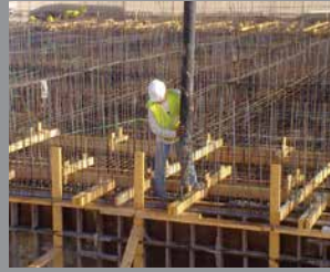
Concreto vertido en sitio
