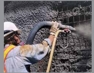
Concreto lanzado
