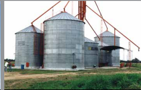
Silos de Almacenaje Calafate, Argentina
